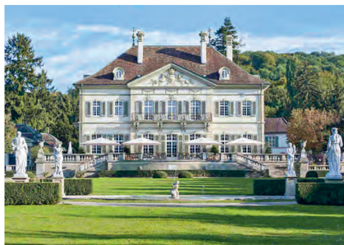
Neuer Wenken, Gartenansicht, Foto: Verwaltung Villa und Reithalle Wenkenhof.
